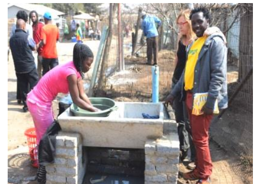
Installation du 1 er lavoir
